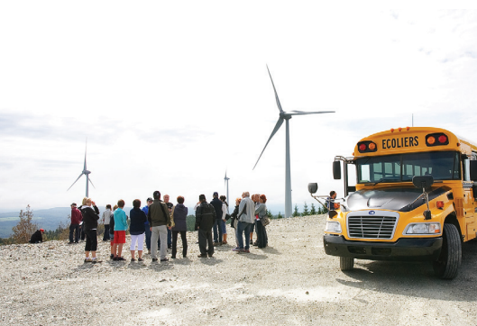
Visite guidée du parc éolien
